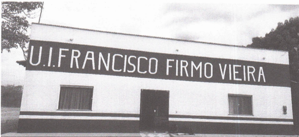
Foto 01: Vista frontal da escola
