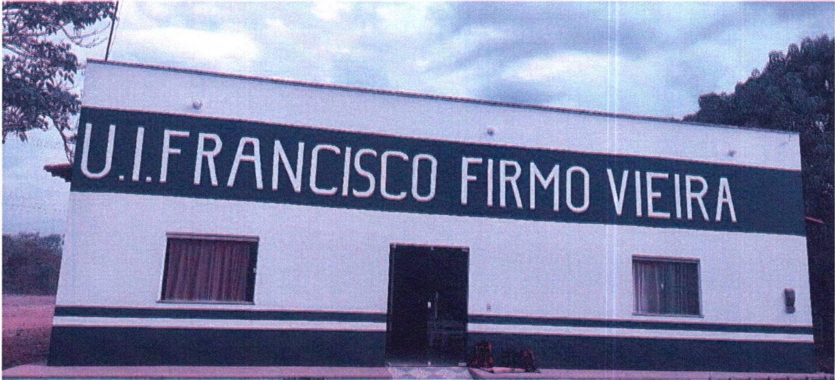
Foto 01: Vista frontal da escola
